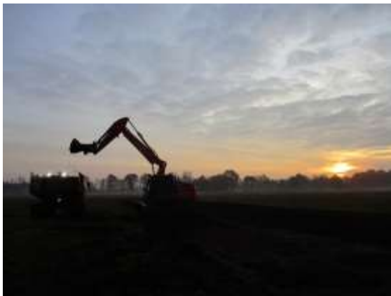
7 Beginn der Baggerarbeiten in Barver (Foto: J.-U. Holthuis)
