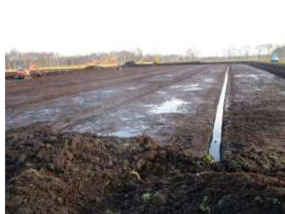
8 Zentimetergenauer Oberbodenabtrag und Anlage von Bewässerungsgräben für die Torfmoosfläche (Foto: J.-U. Holthuis)
