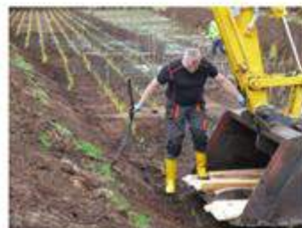
Abbildung 30. Arbeitsschritte bei der Bepflanzung der Filterbecken FB1 und FB2 mit Schilf- und Rohrkolben-Setzlingen (Fotos: Sabine Wichmann)
