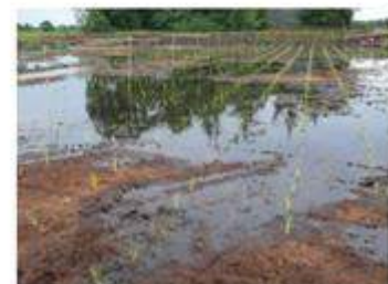
Abbildung 30. Arbeitsschritte bei der Bepflanzung der Filterbecken FB1 und FB2 mit Schilf- und Rohrkolben-Setzlingen (Fotos: Sabine Wichmann)
